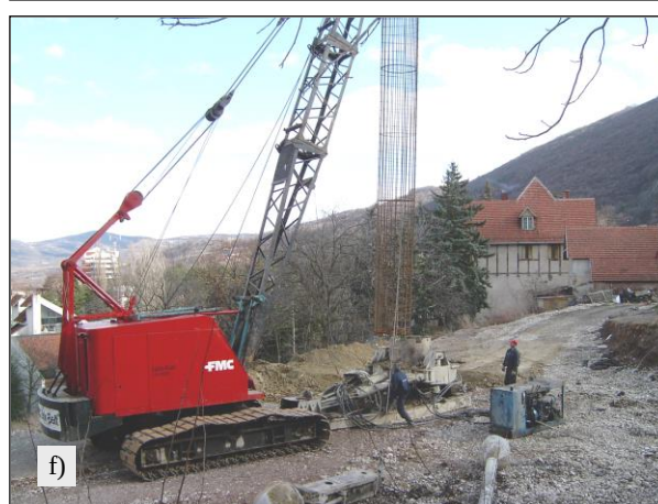
Sl.3. Izvođenje drenažnih objekata (delom u širokom otkopu) i bušenih šipova kroz privremeni nasip Fig.3. Drainage and large diameter bored piles construction
