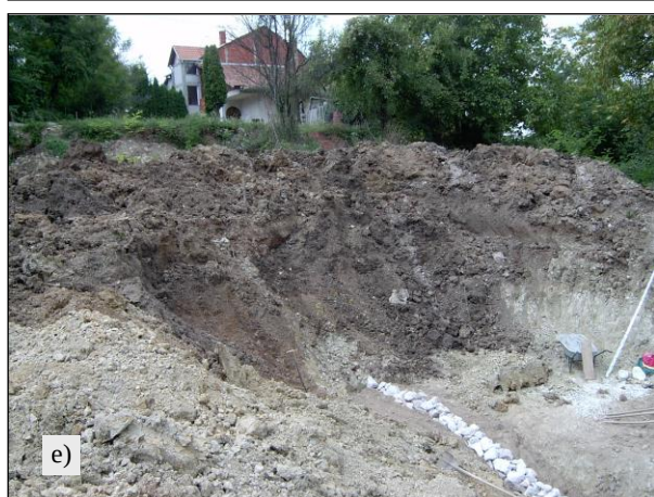
Sl.3. Izvođenje drenažnih objekata (delom u širokom otkopu) i bušenih šipova kroz privremeni nasip Fig.3. Drainage and large diameter bored piles construction
