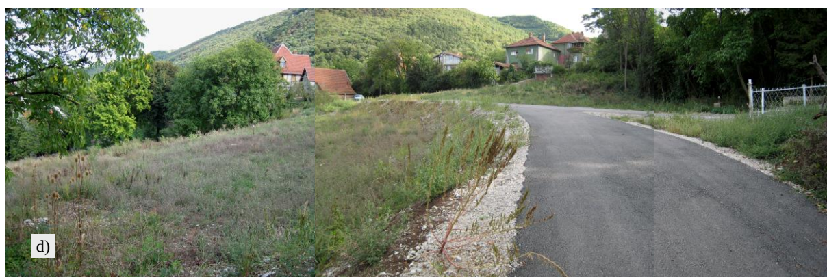
Sl.4. Izvedeni šipovi, ukopani kameni nabačaj i završni radovi saniranog klizišta “Kačarev deo” Fig.4. Constructed piles, rock-fill and final proceeding upon stabilized landslide “Kačarev deo”
